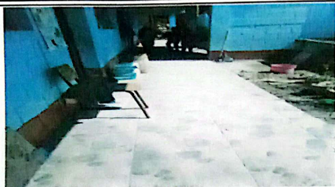
Foto 1: sustitucion de pasillo en el primer nivel
