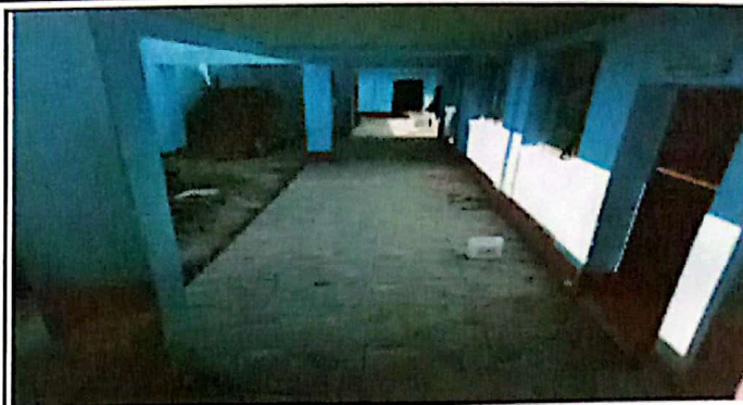
Foto 2: sustitucion de pasillo en el primer nivel
