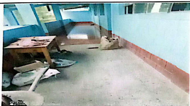
Foto 3: sustitucion de pasillo en el segundo nivel
