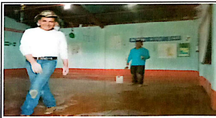
Foto 6: sustitucion de piso en el segundo nivel
